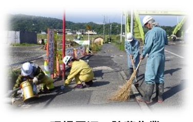
現場周辺の除草作業
