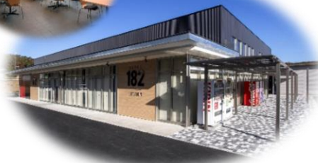
道の駅改築工事
