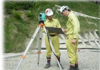
現場測量状況
