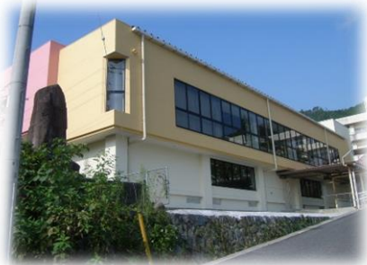
小学校耐震改修工事
